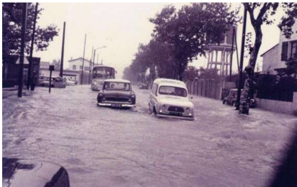
Illustration 21 : Rue de l'hôpital de Perpignan lors de la crue de 1965 (Source DDTM 66)
